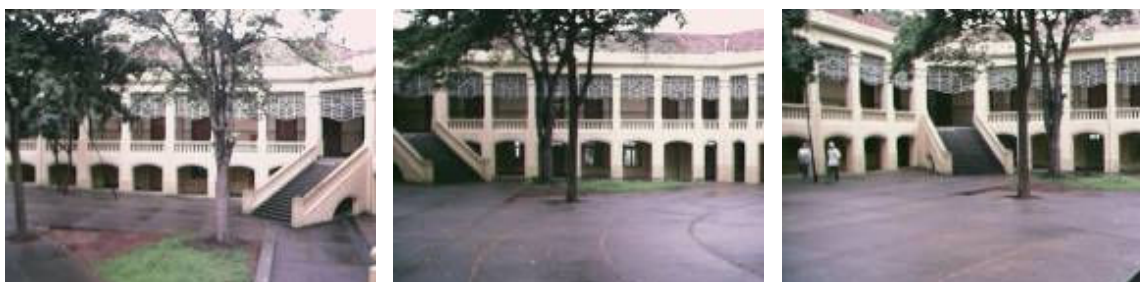
Ilustração 18 - Vistas do pátio. Nota-se que do corredor vê-se o pátio, assim como do pátio é possível observar o corredor de acesso as salas de aula.
