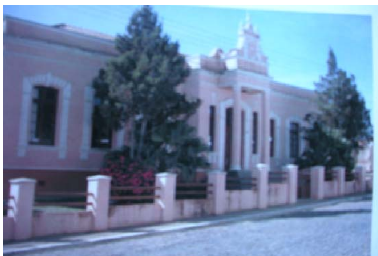
Figura 2 - Prédio do Grupo Escolar Dr. Claudino dos Santos. Hoje atual Casa da Cultura. Fonte: Casa da Cultura.
